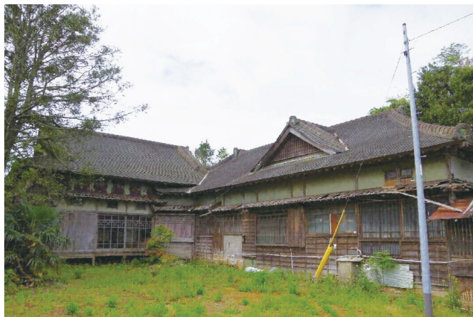
写真1 旧長醫家住宅主屋の全景
