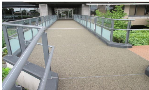
写真 2. 施工例：熊本県庁
